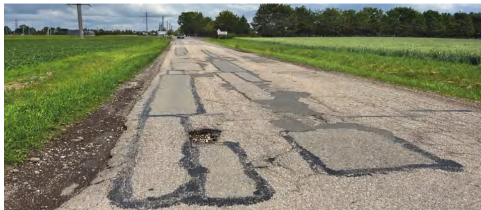
Skaisčiūnų g. rekonstrukcijos turėtų sulaukti iki 2029 m.
