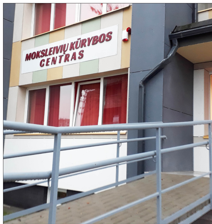
MKC patalpų R. Juknevičiaus gatvėje rekonstrukcija baigta liepą
